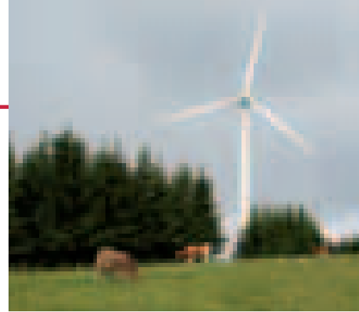
Eolienne du Mont-Soleil (Jura)
