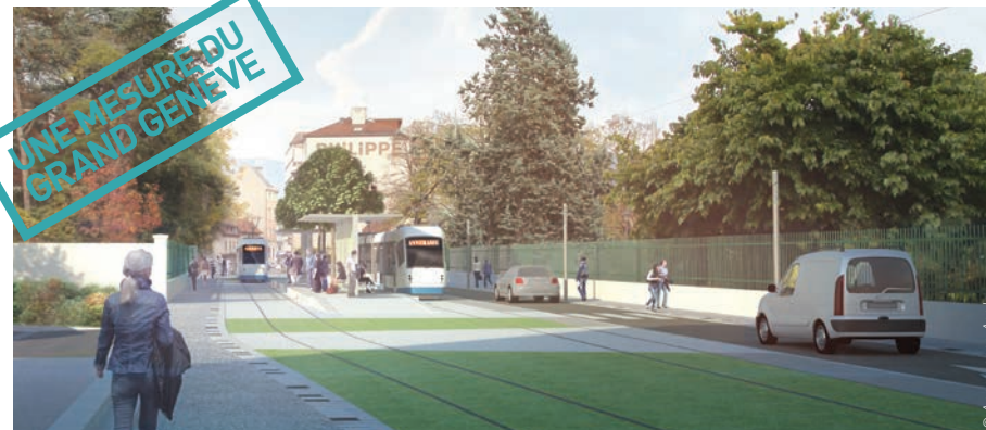
Le prolongement du réseau de tramway vers le centre d'Annemasse, une extension de 3,3km avec 4 stations ouvertes dès fin 2019.
