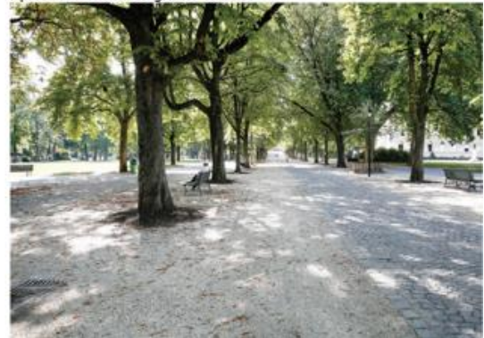
Après : revêtement en gravier stabilisé
