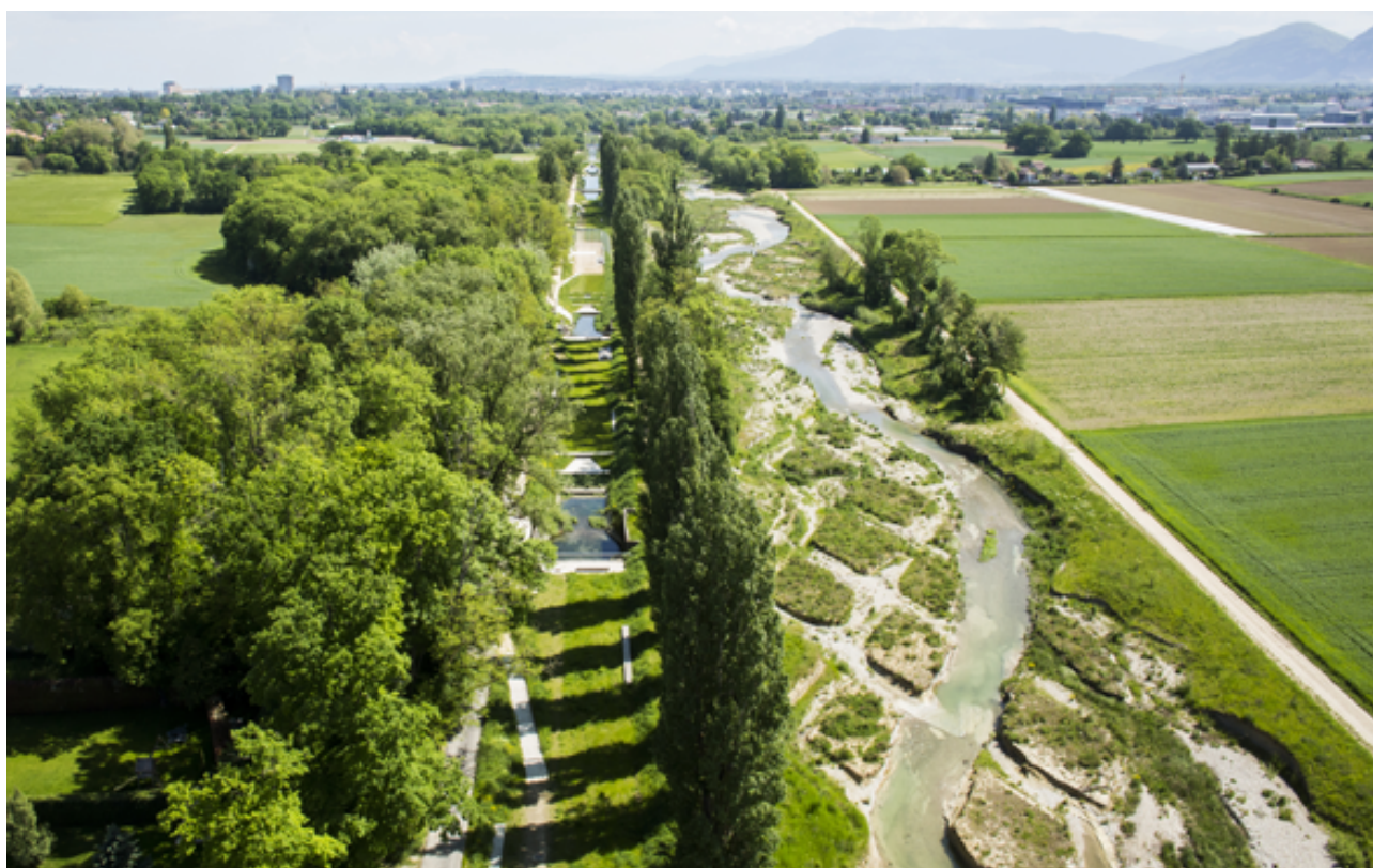
Le tronçon revitalisé s'écoule parallèlement à l'ancien canal, aménagé en parc. © Fabio Chironi
