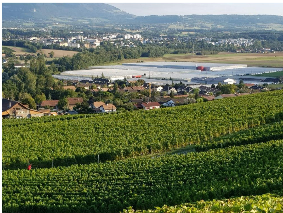
Aperçu des serres construites dans la plaine de l'Aire
