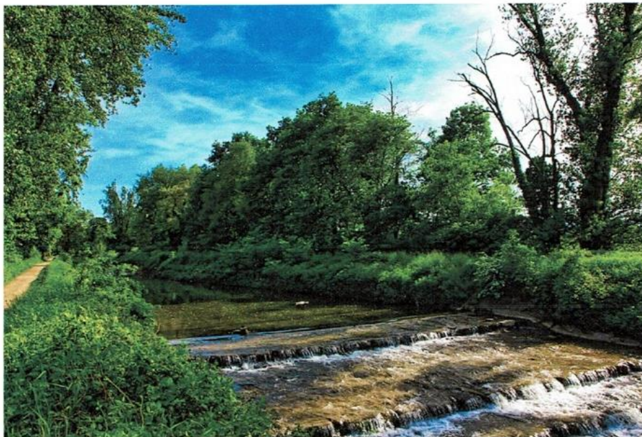
L'Aire à renaturée, vue sur la rive gauche en aval du pont de Perly – 4 ème étape en projet
